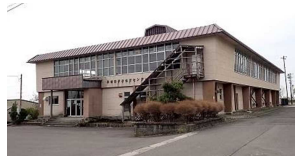
旧平館体育館
