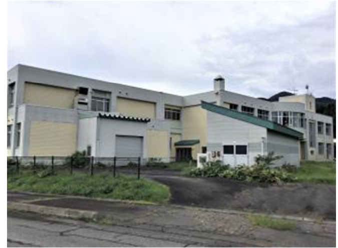
校舎棟裏口・電気室棟
