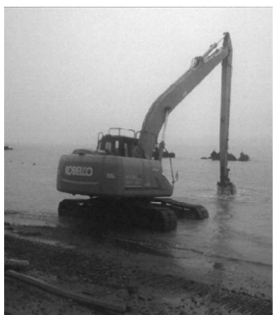
斜路護岸の浚渫作業の様子
