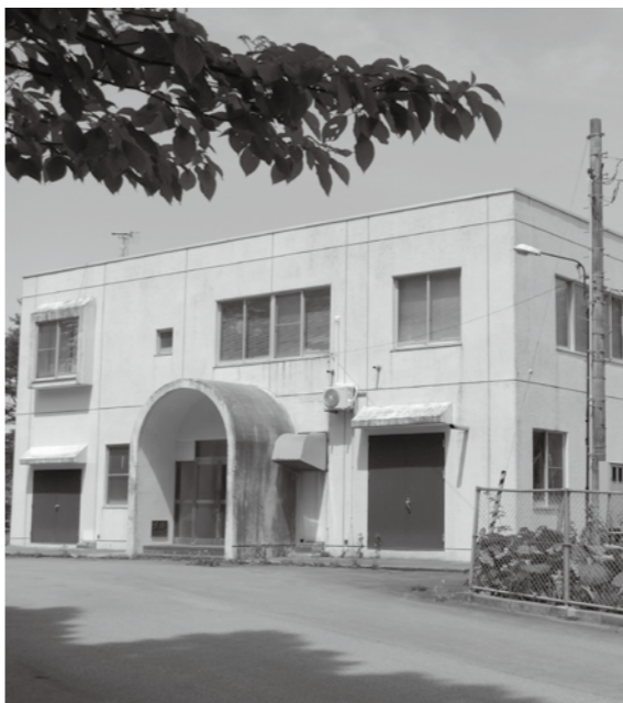
蟹田地区浄水場
