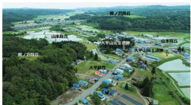
第4図 蟹田川中流域（外ヶ浜町教育委員会提供） A地点の撮影は第2図の⇒印A地点に符合する。 大平段丘は集落、山本段丘は水田として利用。
