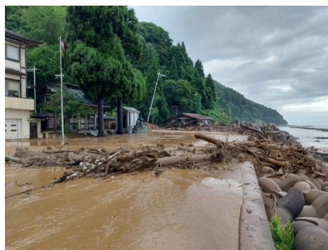
図 2-20 平館元宇田地区の被害状況
