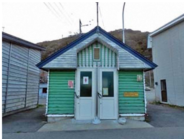
(写真は竜飛漁港階段国道トイレ)
